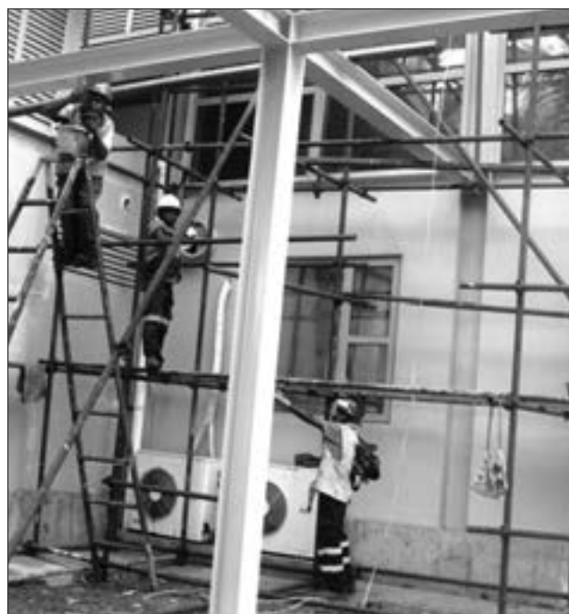
Ol wokman bilong REL i yusim ol skafolding long wok antap na klinim na penim ol ruf bilong hotel.
