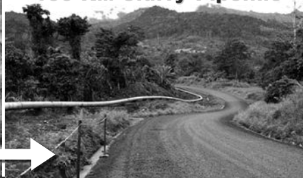
135 KM Slurry Pipeline
